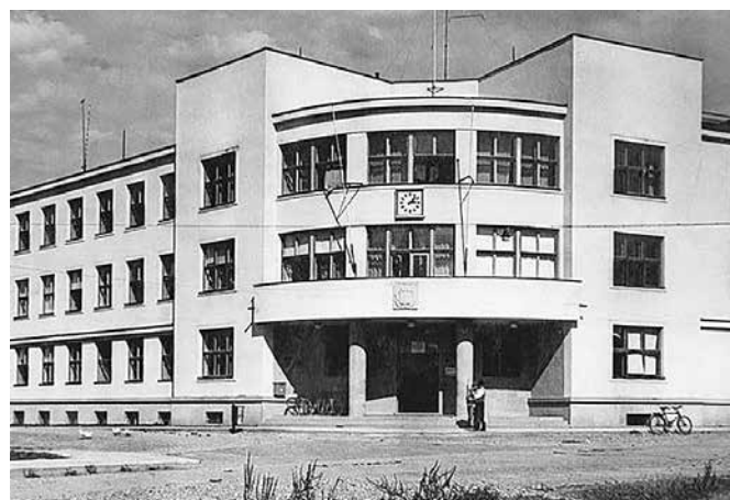
Okresní úřad v Chustu, sídlo VOÚ
